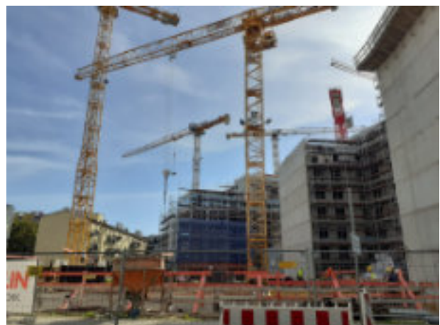
Abb. 6: Baustelle im Ostend (Paul Marques Lindner 2021)
