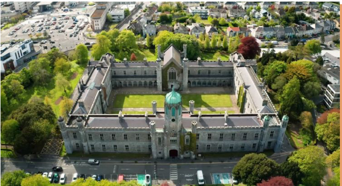
Abb. 1 Gebäude der Universität in Galway (NUIG). Quelle: University of Galway, 2024
